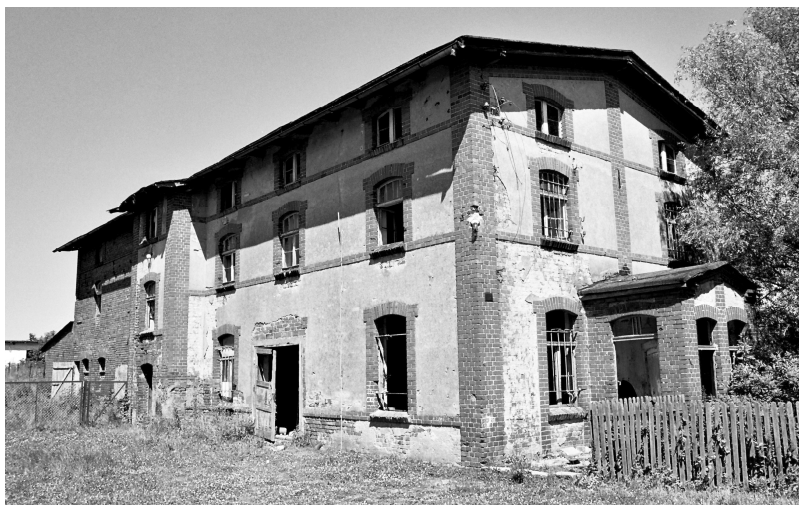
Ryc. 11. Słowino, budynek dawnej fabryki kiełbas i konserw. Fot. W. Witek, 2004 r.
