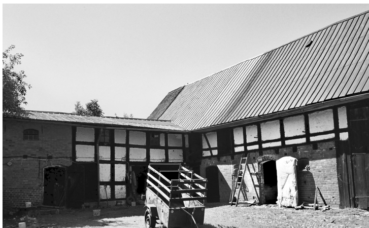
Ryc. 6. Słowino, ryglowe budynki gospodarcze w zagrodzie nr 20. Fot. W. Witek, 2005 r.
