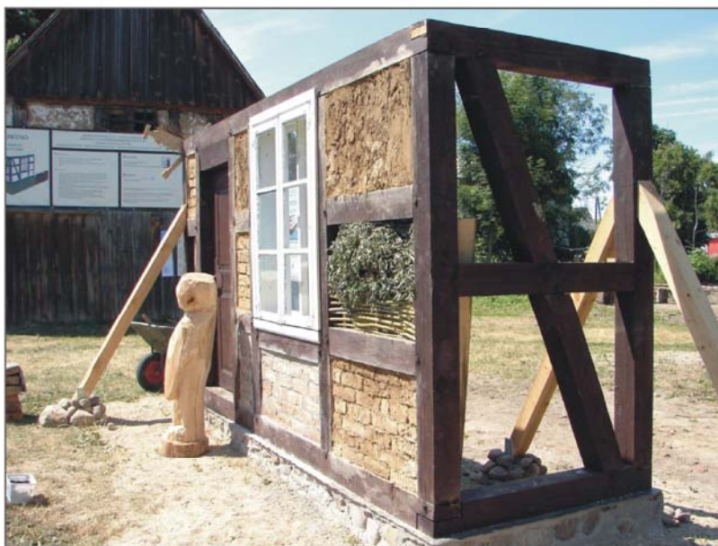
B. Ściana ryglowa w Słowninie. Fot. M. Witek, 2006
