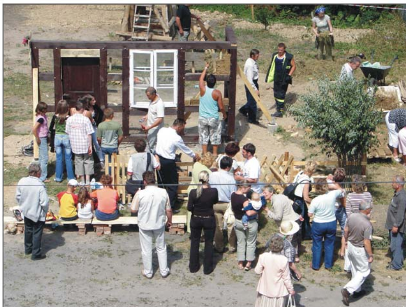
A. Budowa ściany ryglowej. Fot. M. Witek, 2006
