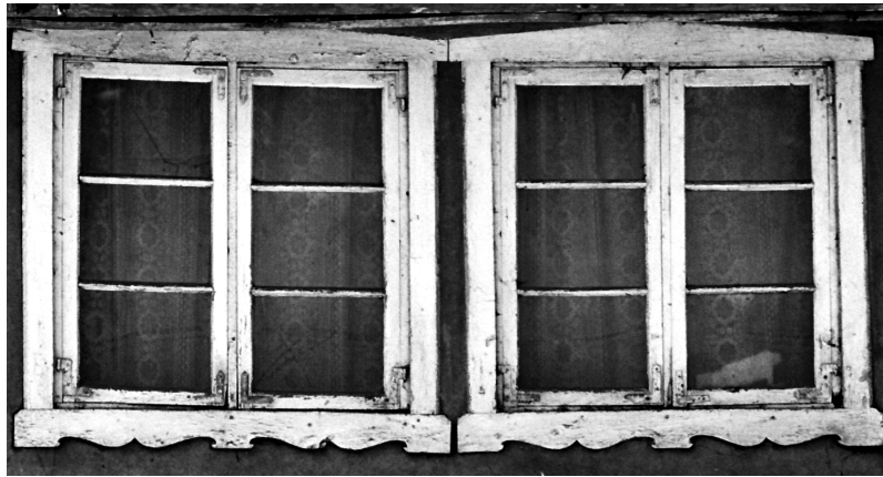
Ryc. 8. Słowino, okna w elewacji frontowej chałupy nr 74. Fot. W. Witek, 2005 r.
